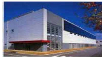
第4分科会 三菱電機株中津川製作所飯田工場
